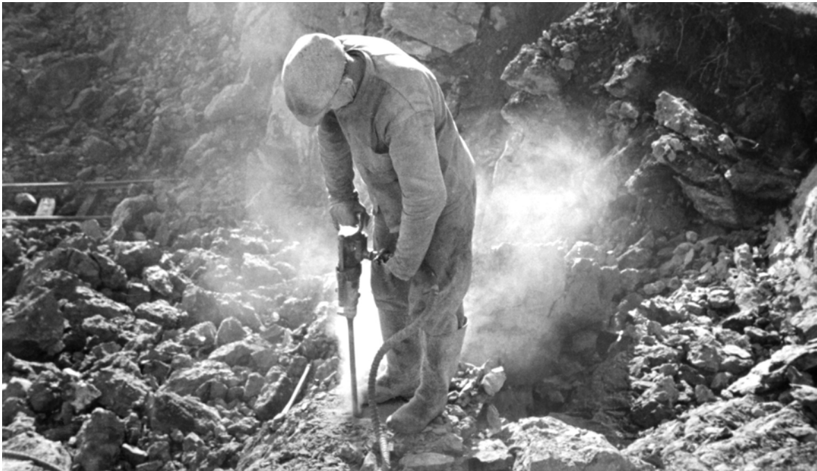
En teknisk revolusjon fant sted fra 1927, da håndboring, slegge, håndtraller og tunge manuelle løft kunne erstattes med jernbane, et moderne steinknuseri, lastebiler og steinskuffer på larveføtter (Lunde, S-T og Hansen, R. 2007 Langøya).
