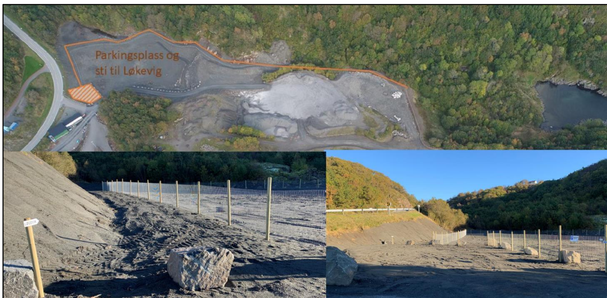
Figur 17: Parkeringsplass og sti til Løgevig
