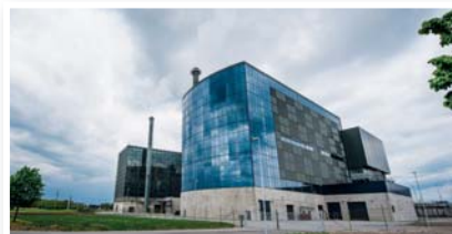
Forbrenningsanlegg for restavfall i Linkøping
