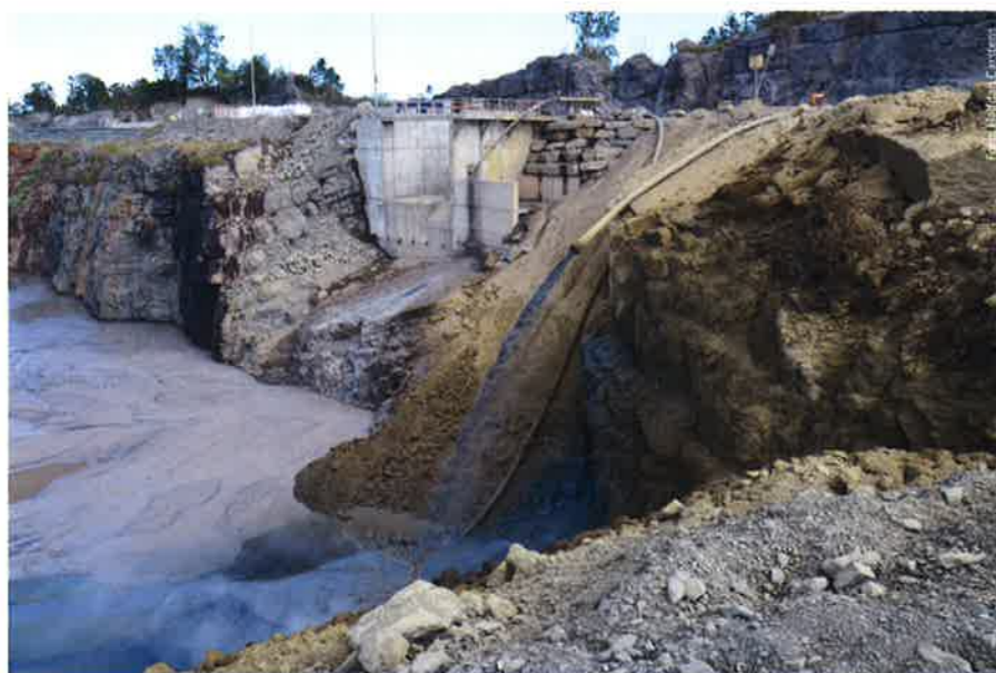
En ferdig prosessert jernholdig gipsslurry pumpes i dag ned i deponiet i Sydbruddet. Her danner gipsen et fundament som skal være utgangspunktet for rehabilitering og gjenskaping av Langøya slik den fremsto før kalksteinsuttaket.
