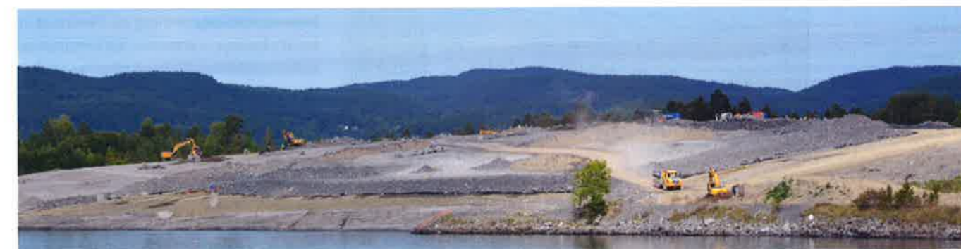
En landskapsarkitekt har fått jobben med å forme fremtidens friluftsareal på Langøya. I høst er mennesker og maskiner i full aktivitet slik det skal stå klart til neste sommer.
